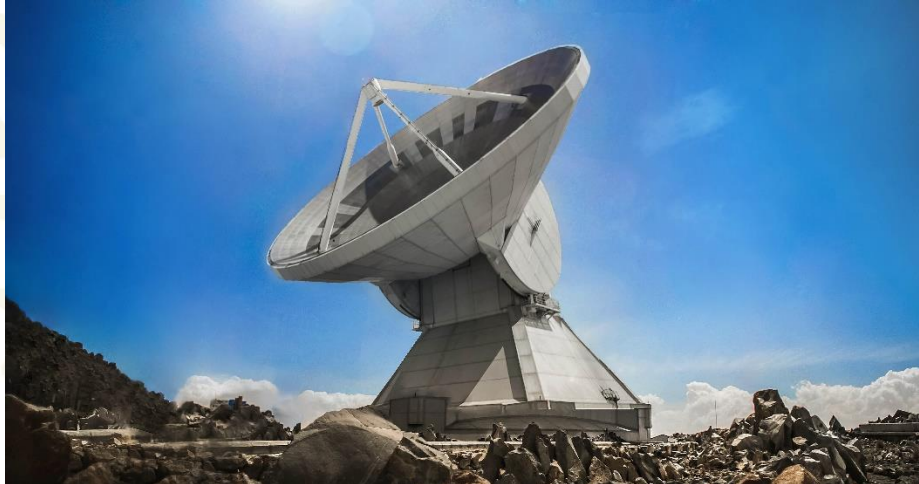
Figura 1. Gran Telescopio Milimétrico con reflector primario completo de 50-m de diámetro
