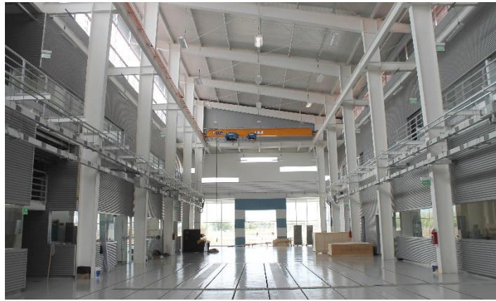
Nave Central, Edificio de Laboratorios
