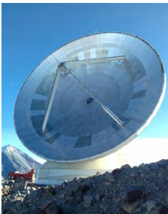
Figura 1. El reflector primario 100% completo (180 segmentos instalados en 5 anillos concéntricos, R1-R5, equivalente a diámetros de 12m–50m) del GTM con diámetro de 50-m. Cada segmento individual consiste de la integración y alineación de 2500 componentes, con el objetivo de construir un segmento de 5m por 2m de dimensiones con una precisión de la superficie de aproximadamente 20-25 micras r.m.s.
