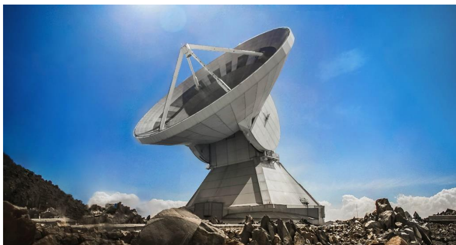
Figura 1. Gran Telescopio Milimétrico con reflector primario completo de 50-m de diámetro
